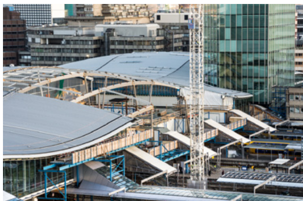
Laatste deel van de nieuwe Stationshal in aanbouw
