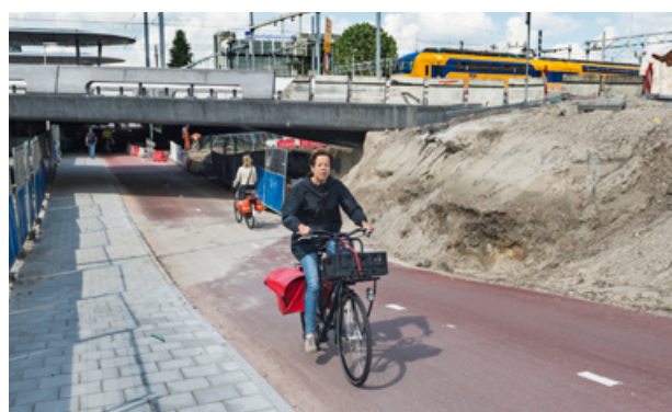
Het fietspad door de Van Sijpesteijntunnel loopt inmiddels rechtdoor onder de HOV-baan.
