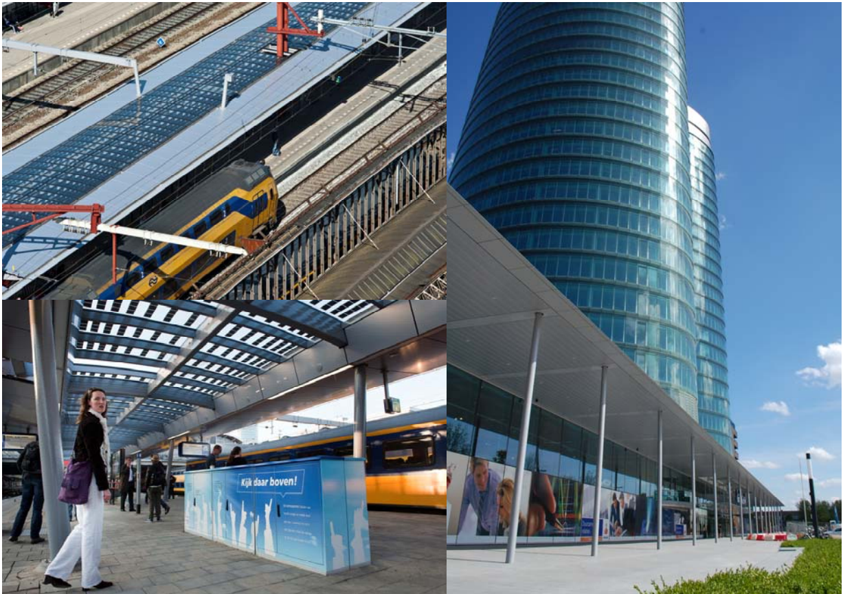
Nieuwe perronkappen op het Centraal Station en het nieuw hoofdkantoor (incl. trottoir) van de Rabobank
