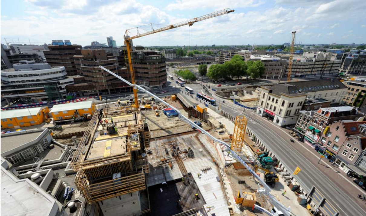
Zicht vanaf de westkern van het Muziekpaleis op het Vredenburgviaduct
