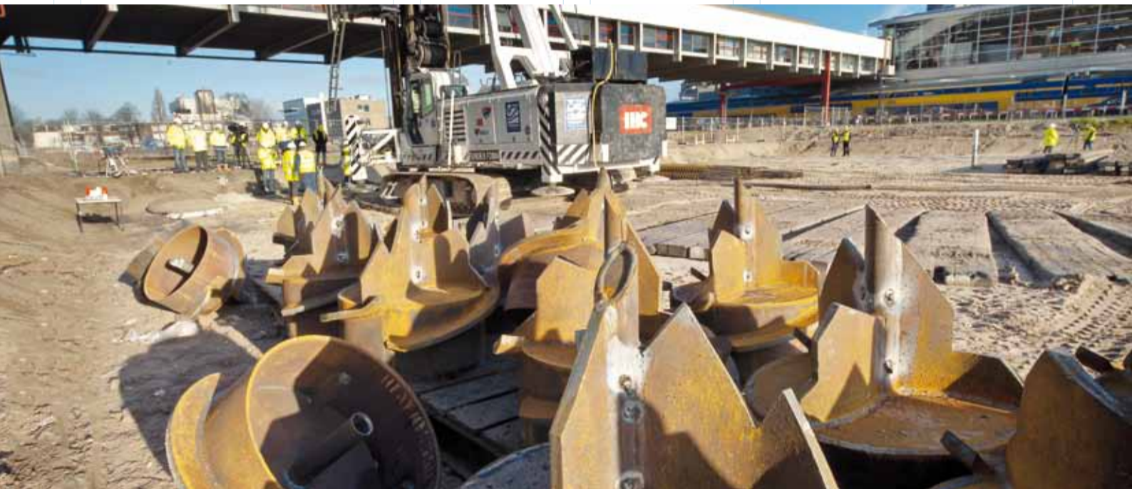
Bouwtrein aan de westzijde station
