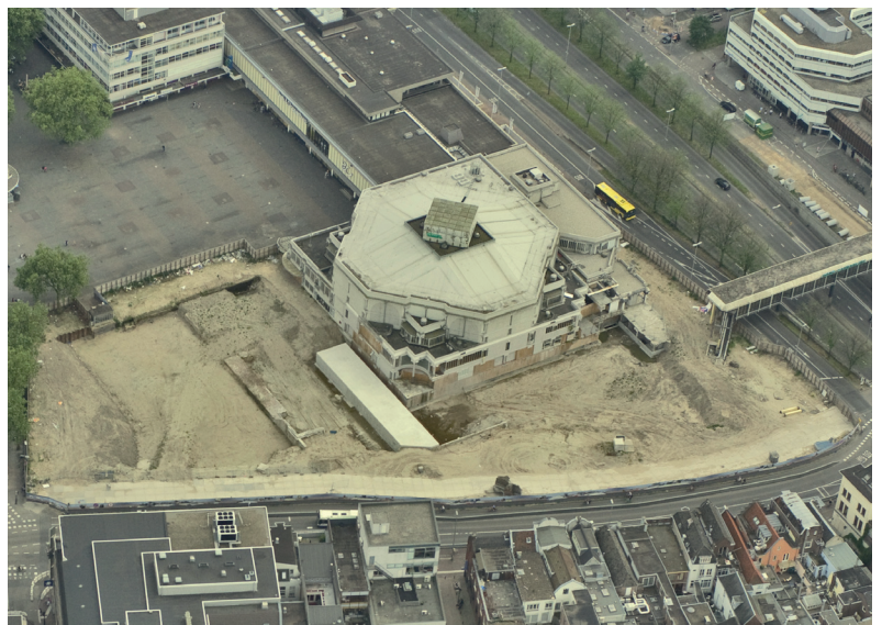
Luchtfoto: bouwterrein Vredenburg
