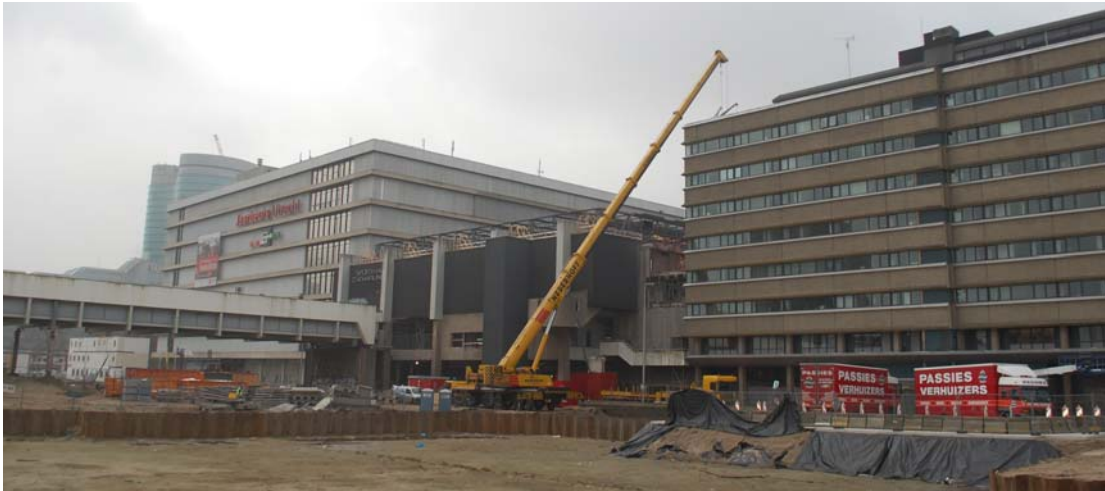
Zicht op de sloop van de sporthal
