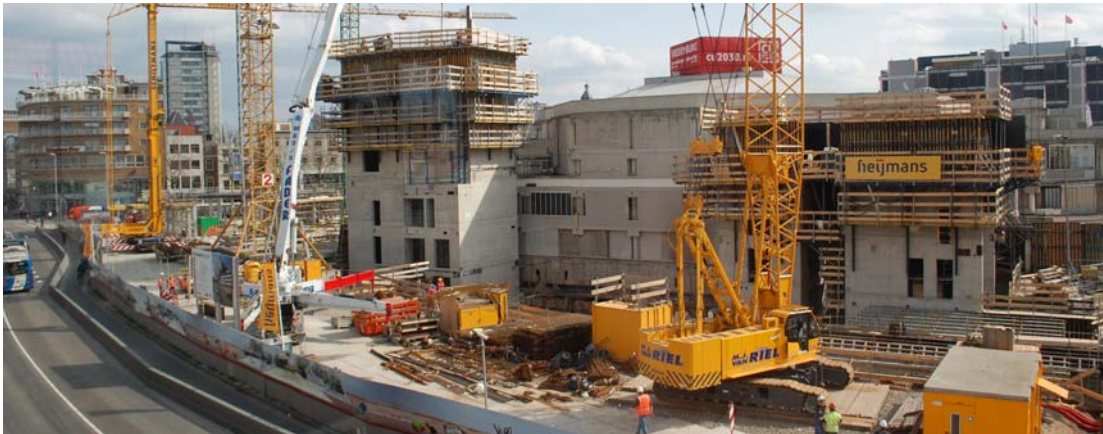
Zicht op de bouw van het Muziekpaleis
