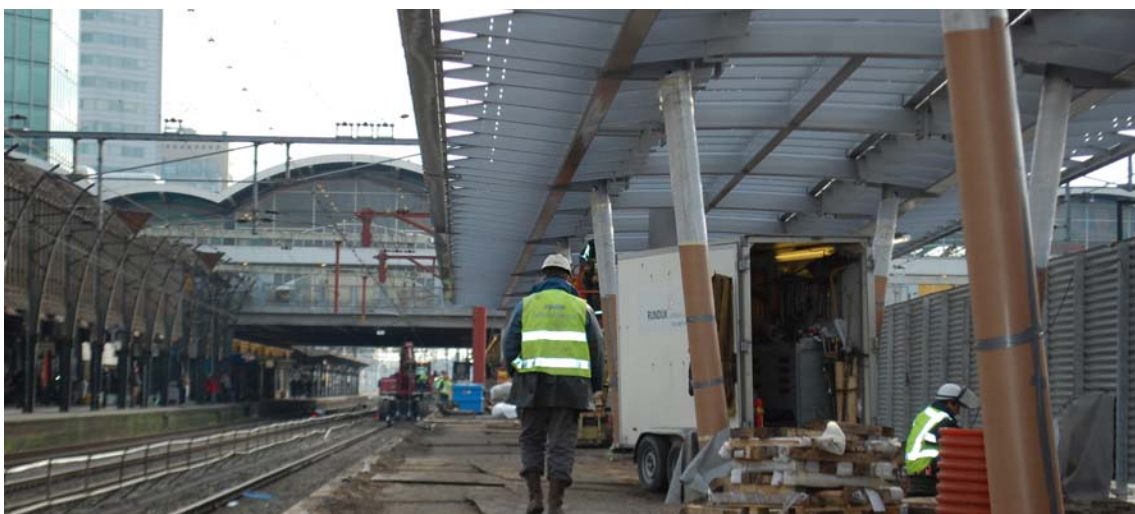
Nieuwe perronkappen op het Centraal Station
