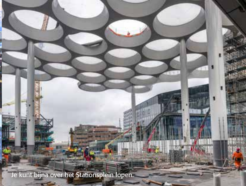
De stationstraverse maakt plaats voor het tweede deel van het Stationsplein en voor de grootste fietsenstalling ter wereld eronder.
