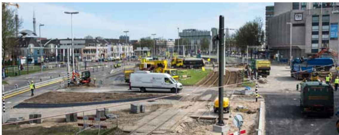
Niet meer gebruikte rails op Westplein
